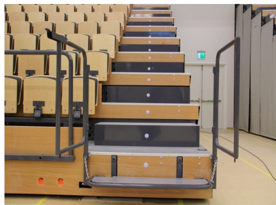
Åpningsbar grind på frontgelender
